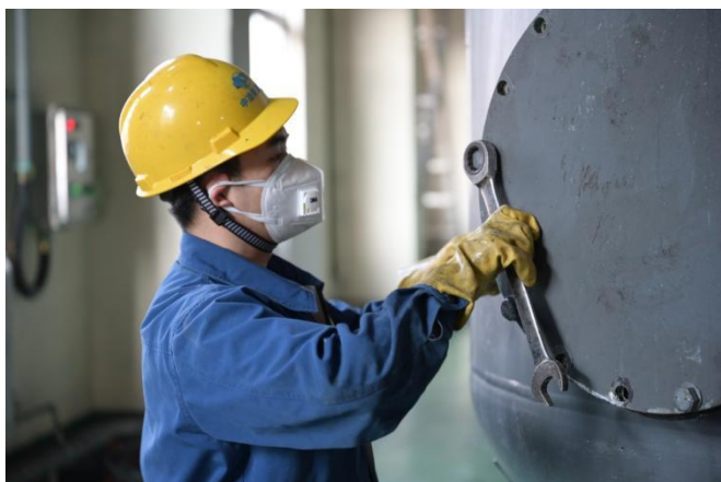
1. 此图拍摄于中冶新能源萃取车间厂房，为保证除油工序的正常运行，员工为活性炭除油罐更换内填料，该图为员工更换完内填料后的场景。
